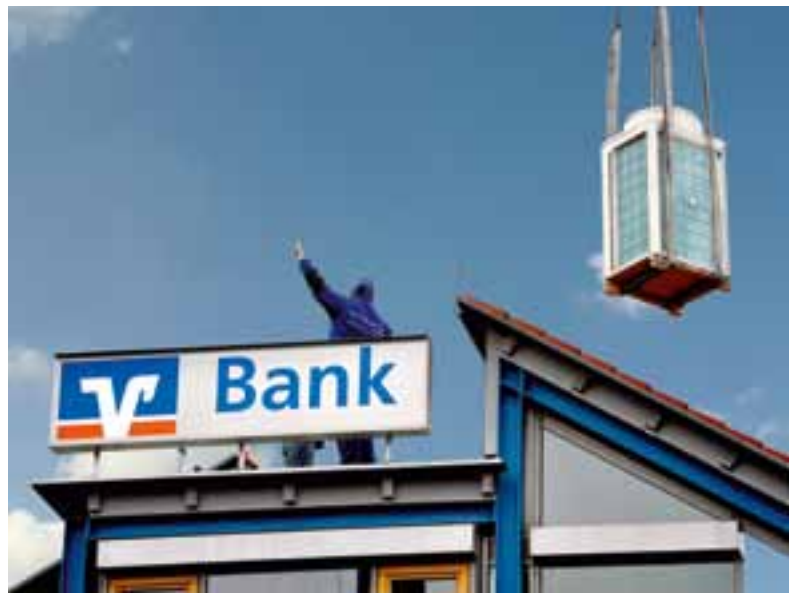
Das neue Replace Multi VRF Außengerät wurde platz sparend auf dem Dach aufgestellt. The new Replace Multi VRF outdoor unit was positioned on the roof to save space.
