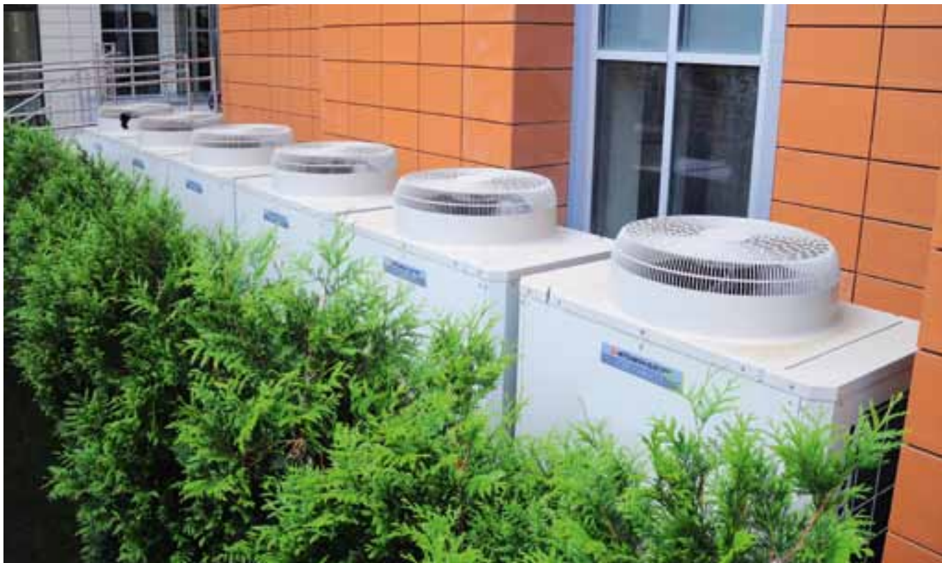
Die über 80 Klimageräte konnten relativ unauffällig im Außenbereich aufgestellt werden. The more than eighty air conditioning units were installed in a relatively discreet outdoor location.
