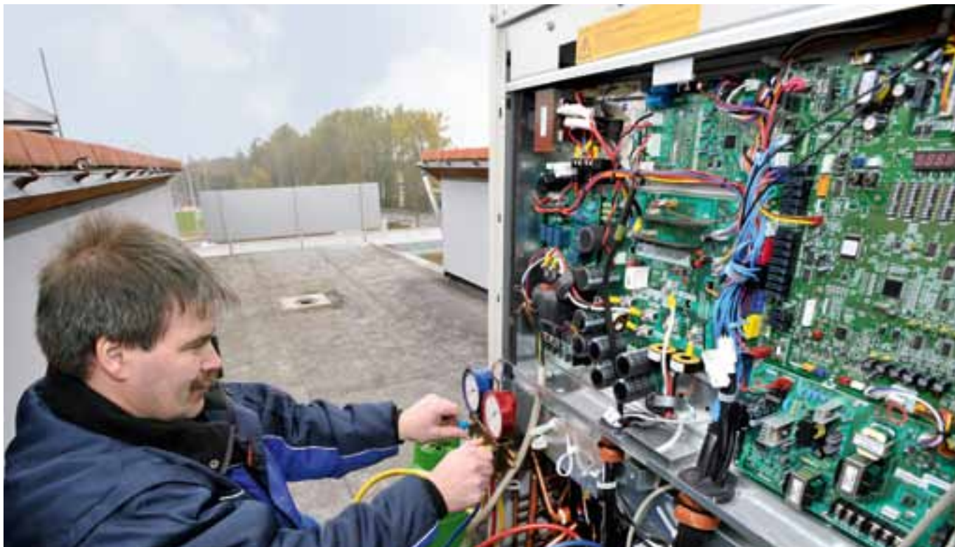
Vor dem Befüllen der neuen Anlage mit dem Kältemittel R410A werden in einem automatischen Spülprozess sämtliche R22 Rückstände aus den Rohrleitungen herausgefiltert. Before filling the new system with the refrigerant R410A, all R22 residues are filtered out of the pipelines during an automatic flushing process.
