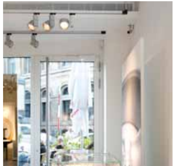
Passend für exklusive Verkaufsräume mittlerer Größe: die Twin-Split-Klimaanlage. Suitable for exclusive sales rooms of medium size: the twin-split air conditioning system.
