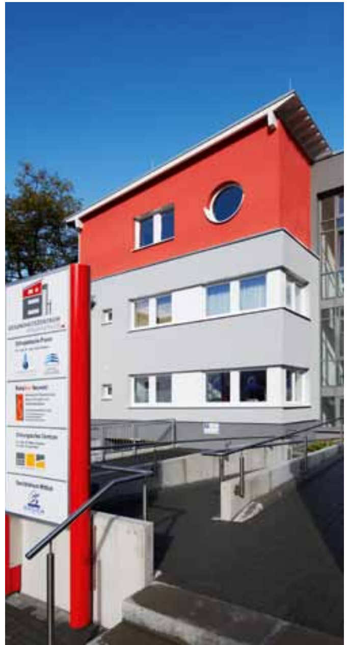
Das Gesundheitszentrum wird komplett über eine VRF-Klimaanlage beheizt und gekühlt. The healthcare centre is fully heated and cooled using a VRF air conditioning system.
