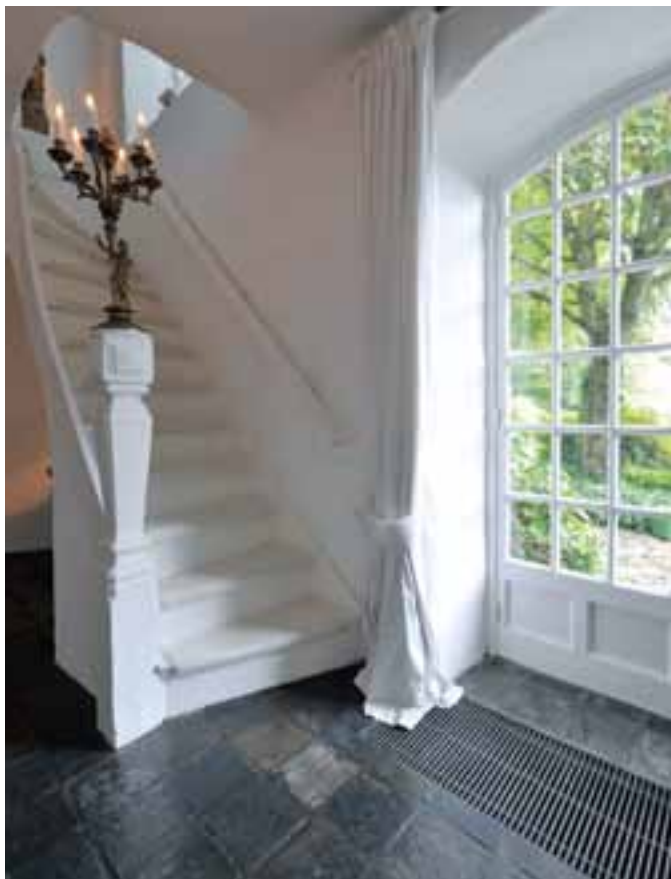
Vor den bodentiefen Fenstern sind Bodenkonvektoren eingelassen, um die Fußbodenheizung des Wohnzimmers mit der nach oben offenen Loggia zu unterstützen. Convactor heaters are embedded in the floor in front of the full-length windows to supplement the floor heating in the living room with its open top loggia.
