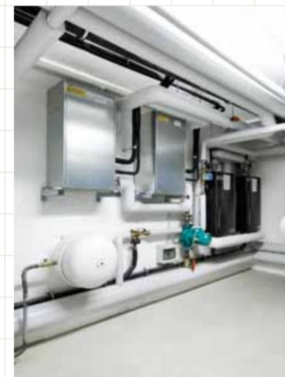
Die überschüssige Wärme aus den Sporträumen – insbesondere zu Stoßzeiten – wird abgeführt und für die Heizung oder zur Warmwasserbereitung genutzt.
