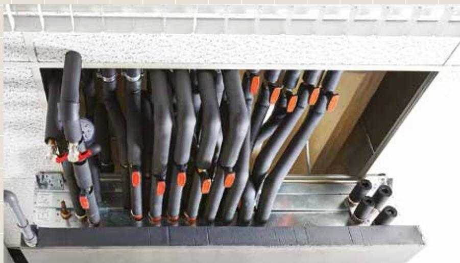
Das Kernstück der neuen Technologie ist der Hybrid BC-Controller: Hier wird Wärmeenergie von Kältemittel auf Wasser übertragen.
