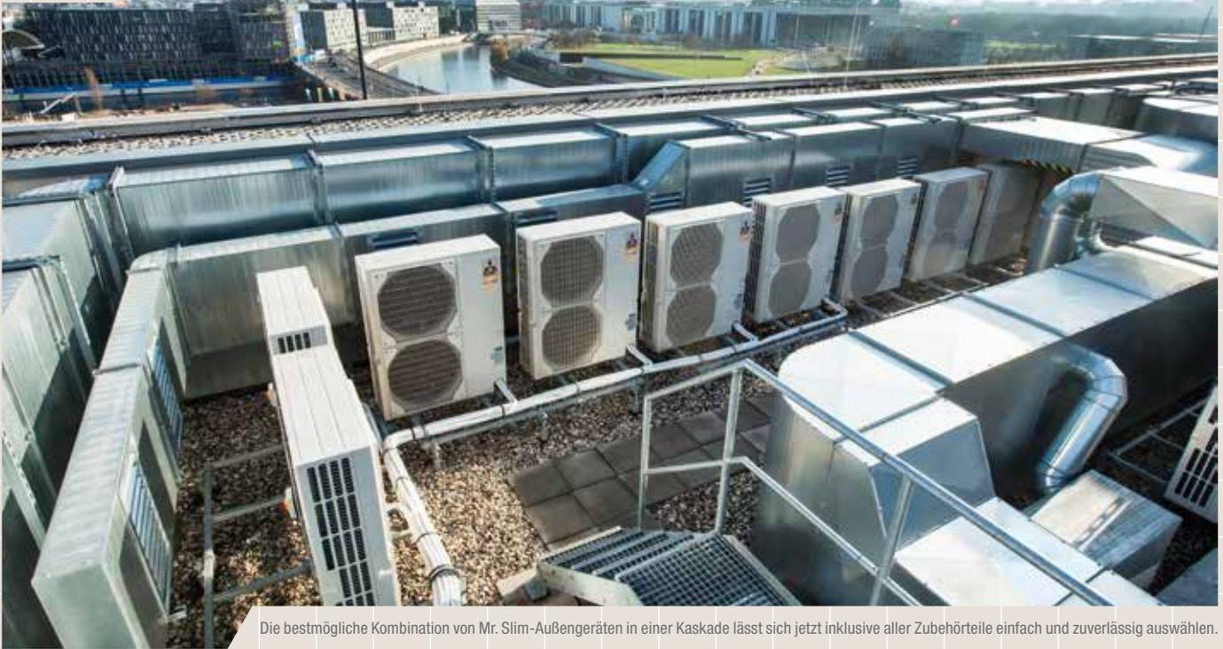
Die bestmögliche Kombination von Mr. Slim-Außengeräten in einer Kaskade lässt sich jetzt inklusive aller Zubehörteile einfach und zuverlässig auswählen.
