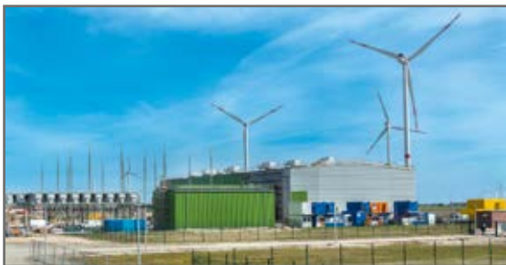
Wassergekühlte VRF-Systeme für Windpark Emden Ost
