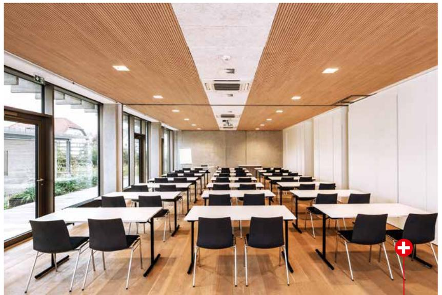
Im Erdgeschoss werden unterschiedliche Bereiche – hier der große Besprechungsraum – mit 4-Wege-Deckenkassetten klimatisiert.
