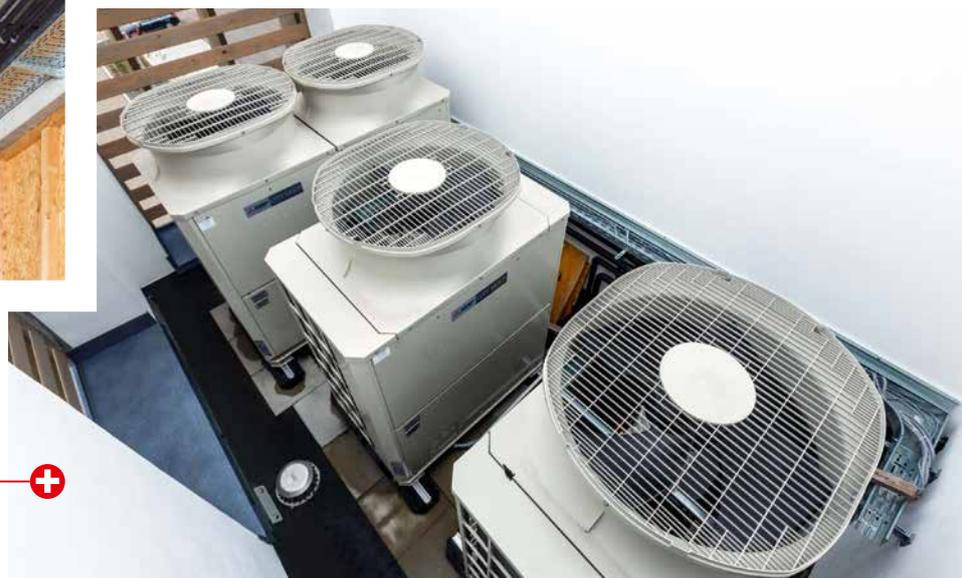
Drei HVRF-Außengeräte aus der City Multi Serie mit unterschiedlichen Leistungen befinden sich auf einem eingehausten Seitendach.
