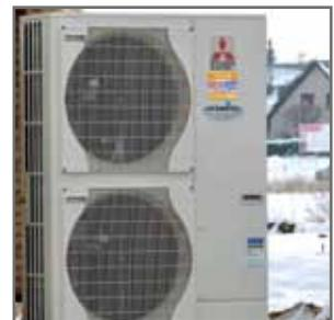
**Kaskadenlösung mit Luft-/Wasser-Wärmepumpen**
