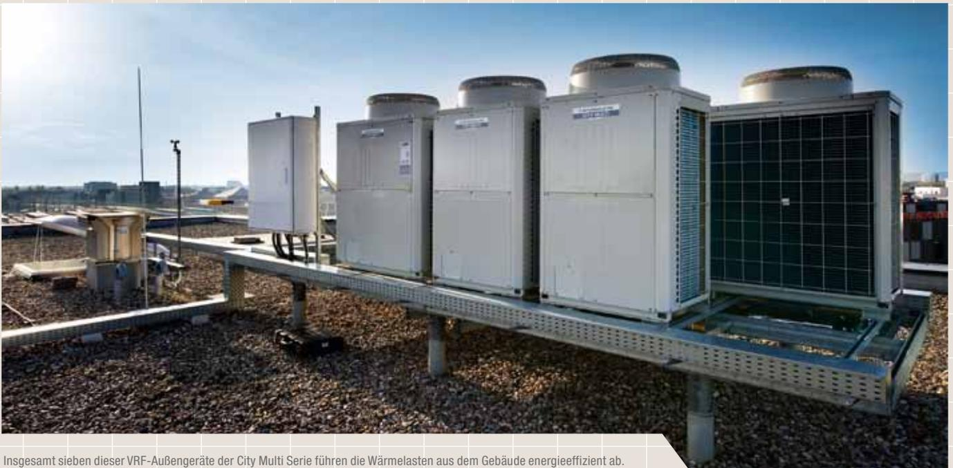
Insgesamt sieben dieser VRF-Außengeräte der City Multi Serie führen die Wärmelasten aus dem Gebäude energieeffizient ab.
