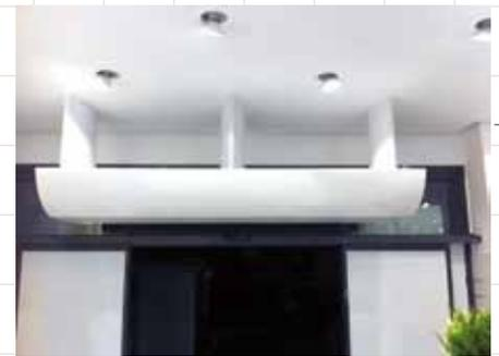
Als Unterdeckenkonstruktion macht der neue Türluftschleier HX2 eine gute Figur.
