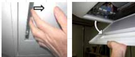
Erleichterte Wartung dank Luftfilterschiebeklappen an der Unterseite des Gerätes.
