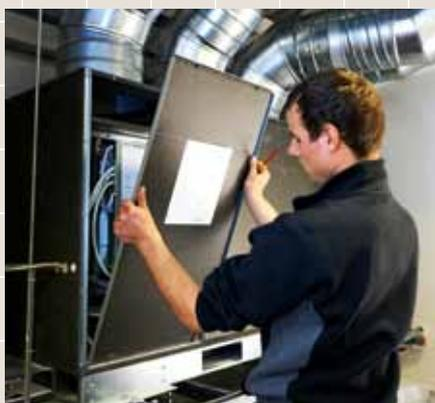
Der individuell einstellbare Luftvolumenstrom der Zu- und Abluftventilatoren ermöglicht es, in den Räumen einen Überdruck oder Unterdruck zu fahren. Je nach Anwendung kann so die Luft im Raum gehalten oder auch aus dem Raum herausbefördert werden.
