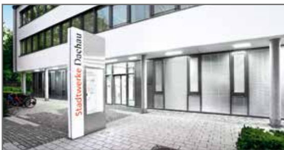
Stadtwerke Dachau mit nachhaltigem Energiekonzept
