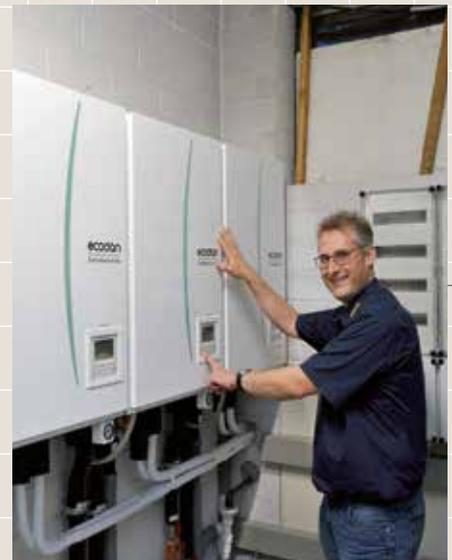
Die Innengeräte der Wärmepumpe wurden im Heizungsraum montiert. Jochen Reuter hat die energetische Sanierung als Projektleiter geplant und umgesetzt.
