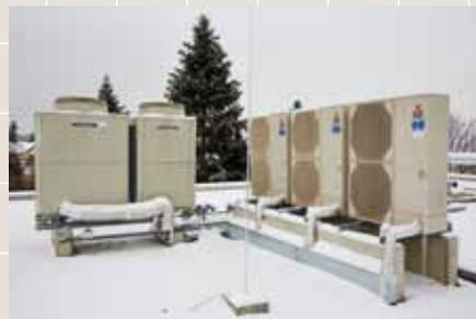
Das Außengerät aus der City Multi Serie (li.) und die drei Power Inverter Redundanz-Geräte sorgen zuverlässig für eine ganzjährige Kühlung des Rechenzentrums.
