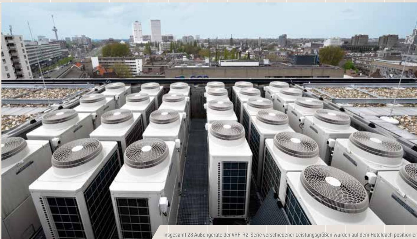
Insgesamt 28 Außengeräte der VRF-R2-Serie verschiedener Leistungsgrößen wurden auf dem Hoteldach positioniert.
