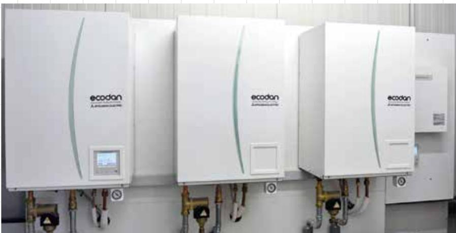
Drei Hydromodule übertragen die Wärme vom Kältemittel- auf den Wasserkreislauf und übernehmen grundlegende Funktionen.
