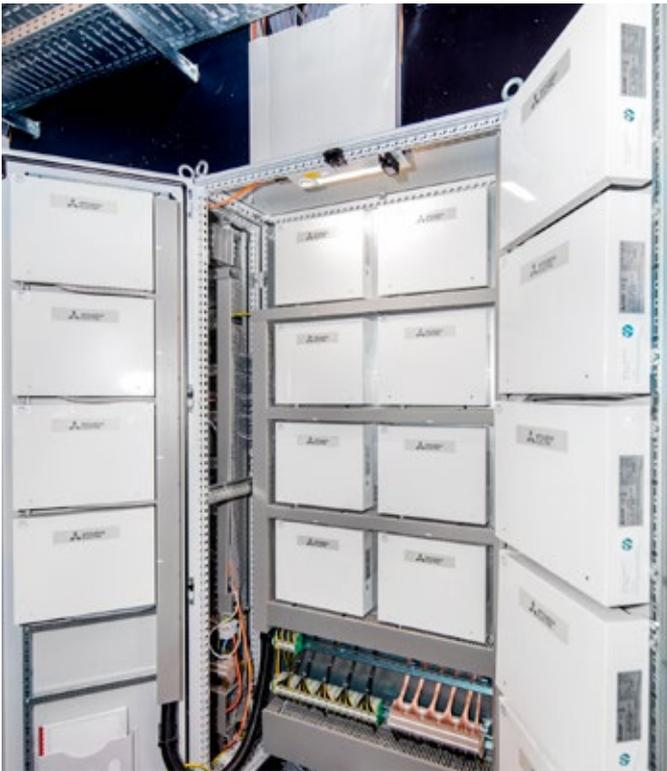
Die reibungslose Kommunikation zwischen den Wärmepumpen der Mr. Slim-Serie und den bauseitigen Wärmetauschern der Lüftungsgeräte erfolgt über Anschlusskits vom Typ PAC-IF013B-E.
