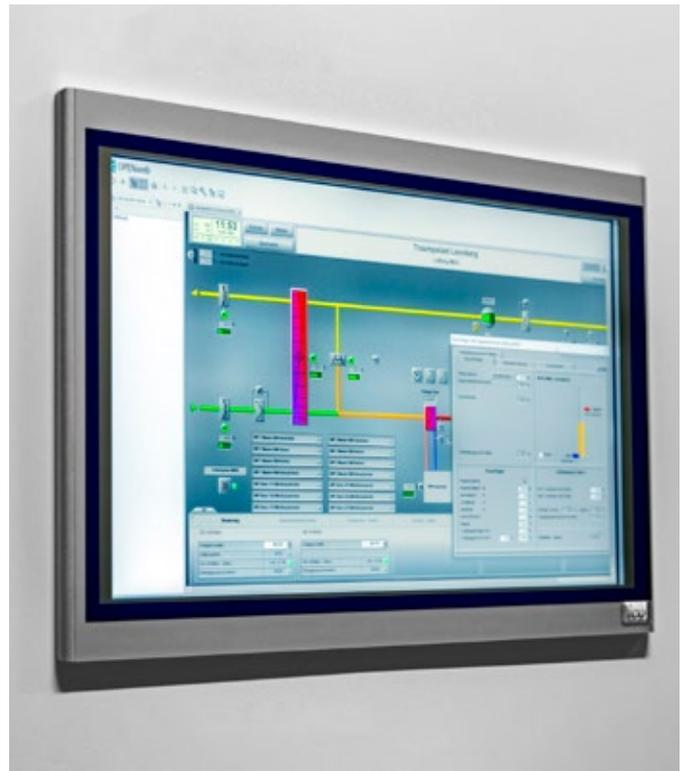
Zur Steuerung und Überwachung sind die Anlagen in eine übergeordnete Gebäudeleittechnik (GLT) integriert.
