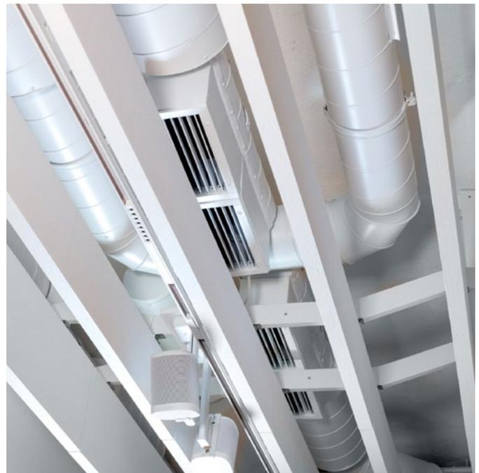
Die Lossnay-Lüftungsgeräte versorgen den Gewölbekeller über ein kontrolliertes Lüftungssystem mit 100 % Frischluft, ohne dass spezielle Virenfilter eingesetzt werden müssen.
