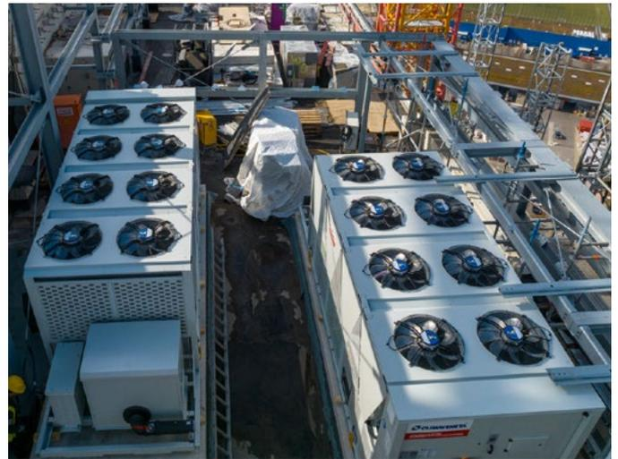
Zum Einsatz kommen Kaltwassersätze von Climaveneta, einer Marke von Mitsubishi Electric vom Typ i-FX-G05 mit Kälteleistungen zwischen 599 und 842 kW.
