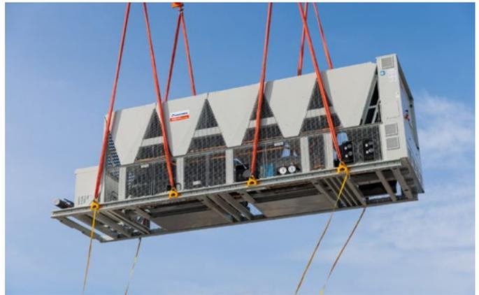
Mit einem Gewicht zwischen 6.700 und 9.700 kg wurden die Geräte in einem Zeitfenster von nur drei Stunden mit einem bauseitigen Kran in 142 m Höhe auf das Dach des Gebäudes gezogen.
