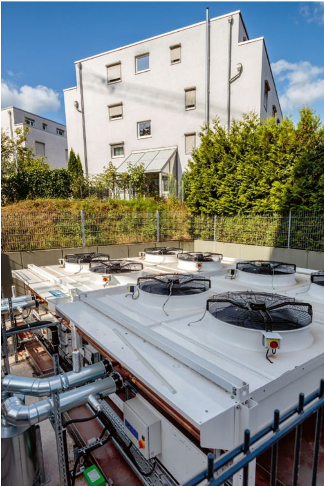
Großzügig ausgelegte Trockenkühler im Außenbereich mit niedrigen Ventilator Drehzahlen reduzieren die Schalleistung auf ein Minimum.
