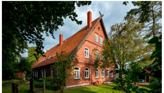
Das Wohngebäude hat eine Wohnfläche von rund 320 m 2 und war bereits in Teilen saniert.
