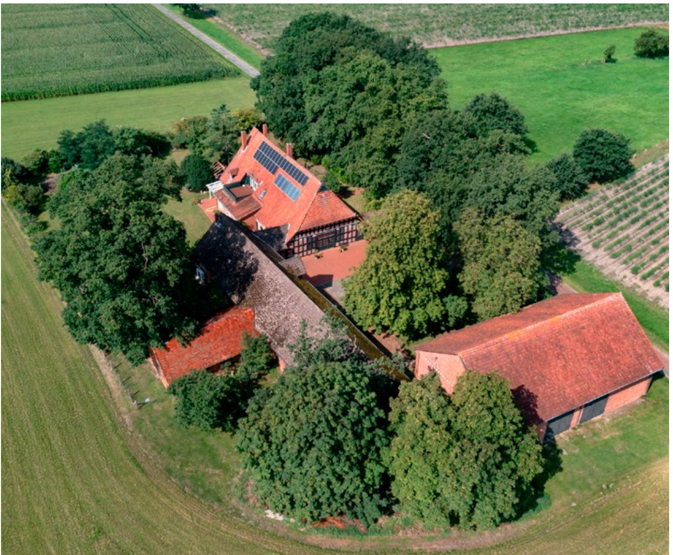
Ein ehemaliger Pferdehof in Niedersachsen wird seit Kurzem mit Raumwärme und Trinkwarmwasser versorgt, ohne dafür fossile Brennstoffe zu nutzen.
