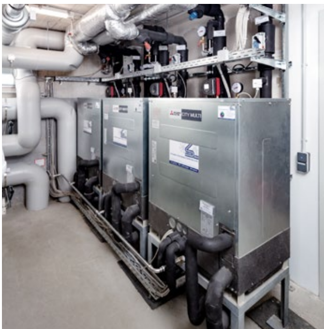
Mit den wassergeführten Außengeräten zur Innenaufstellung – auch Wassermodule genannt – setzt Mitsubishi Electric einen hohen Standard und weitet mögliche Anwendungsbereiche für das Hybrid VRF-System deutlich aus.
