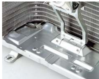
Gleicher Betriebszustand am Außengerät mit integrierter Wannenheizung
