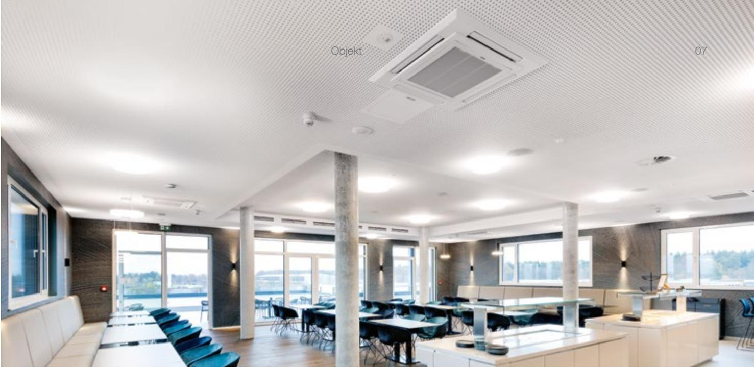
Der Küchenbereich wird über eine raumlufttechnische Anlage mit frischer Luft versorgt. Die Zuluft wird durch Außengeräte der Mr. Slim-Serie vorkonditioniert.
