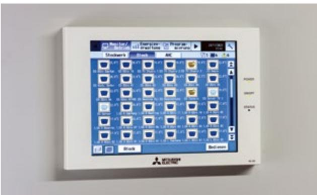
Sämtliche Klimageräte sind in eine übergeordnete Gebäudeleittechnik mit KNX-Standard eingebunden und können über eine Systemsteuerung mit der Zentralfernbedienung AE-200E von Mitsubishi Electric bedient werden.
