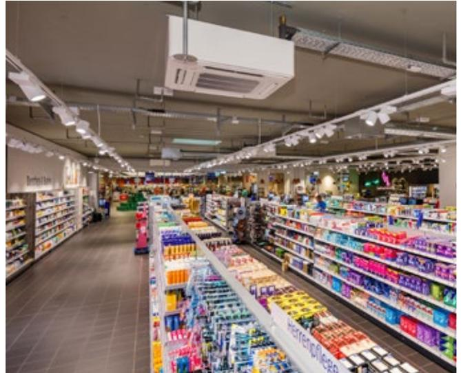
Die insgesamt vierzehn 4-Wege-Deckenkassetten gewährleisten eine zugfreie Luftumwälzung im Bereich der Verkaufsfläche.
