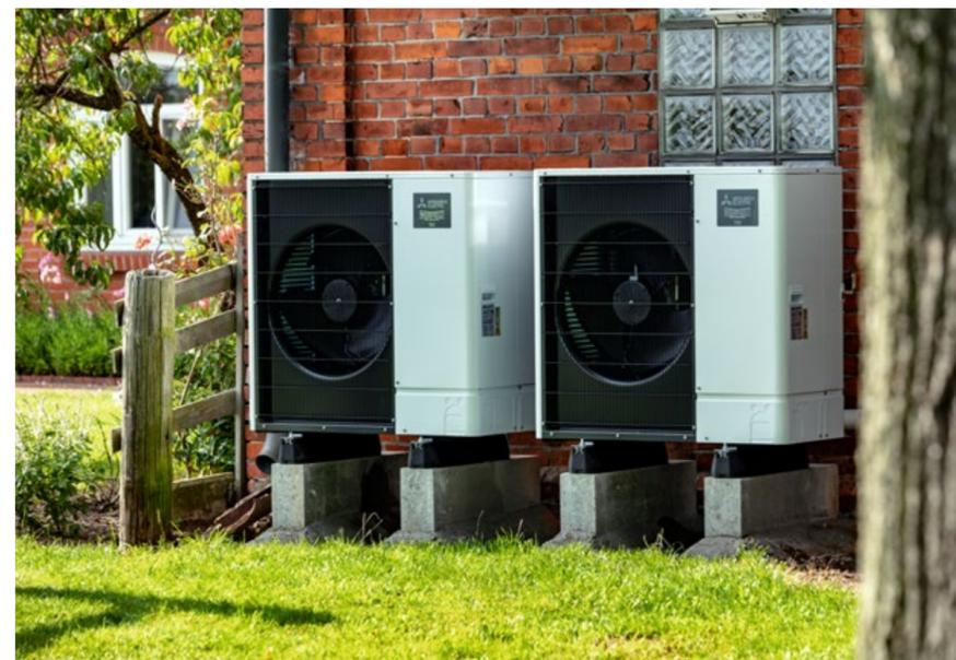
stehenden Heizung auf 50 °C abgesenkt. „Wenn sich damit die gewünschte Raumtemperatur auch bei niedrigen Außentemperaturen erreichen lässt, kann eine Luft/Wasser-Wärmepumpe grundsätzlich effizient betrieben werden“, erläutert Klaus Schierenbeck.
