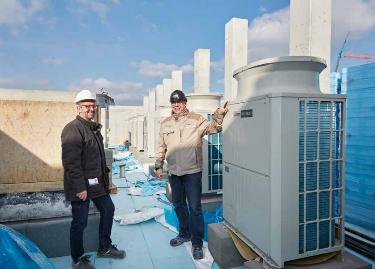
Dach der Baustelle vom Hampton Indigo Hotel in Berlin.
